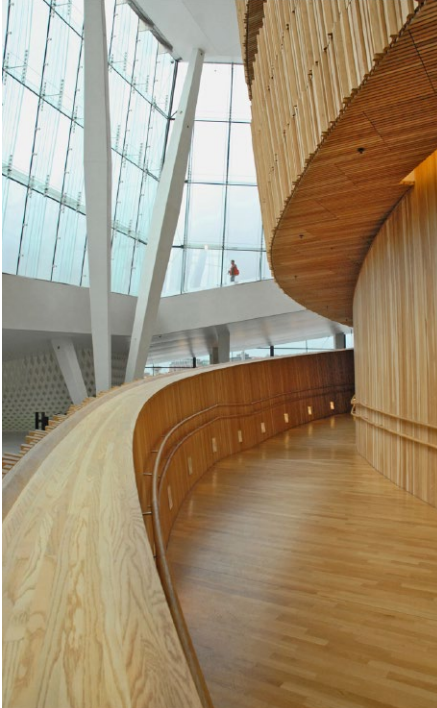
Bild 5. Rampe innerhalb der Wand aus Eichenholz
